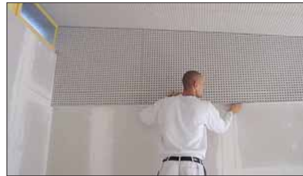
Die Unterdecke aus „Rigiton Air“-Lochplatten wurde mithilfe von Hutdeckenprofilen direkt auf die Strahlenschutzdecke montiert.
