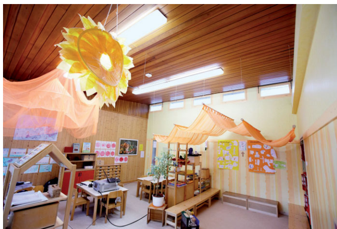
Bild 3. Im Inneren des Gruppenraumes fanden die Strahlenexperten vor allem viel beschichtetes Holz und einfachen Gipskarton an Wänden und Decke vor, die Raumakustik war schlecht
